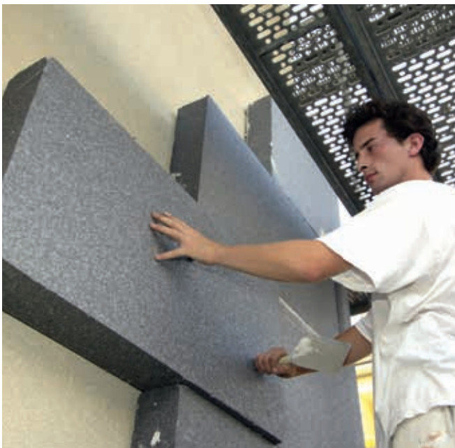
Die richtige Verarbeitung durch einen Fachhandwerker sorgt zusätzlich für die Sicherheit von EPS-Fassaden.
