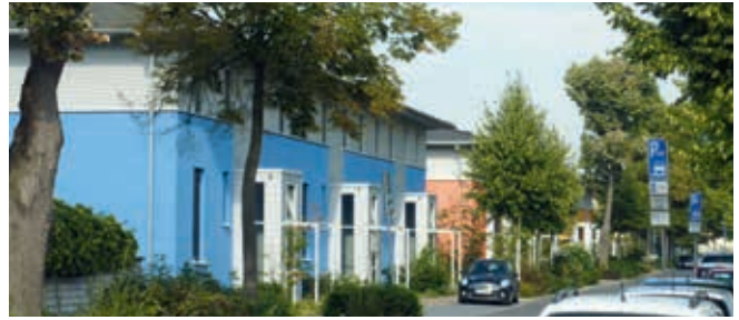
Die Fallstudie Brunckviertel zeigt: Energieeffizienzmaßnahmen nutzen Mietern und Vermietern gleichermaßen.
